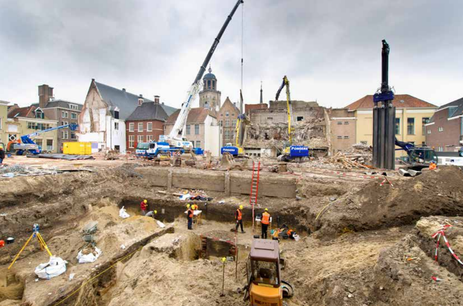
Op de plek waar nu panden worden gesloopt komt straks een van de meest duurzame gebouwen van Nederland te staan.
