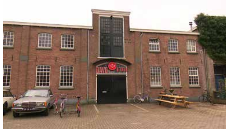
Het Sluiskwartier is het afgelopen jaar al op plekken opgeknapt. Zo heeft Davo Bieren intrek genomen in de voormalige machinefabriek van molenmakerij Ten Zijthoff.
